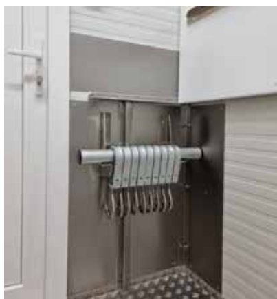
Anbringen eines Hakenbahnhofs.
