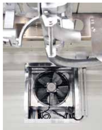
Kühlraum bis 2°C temperierbar mit bündigem Wandeinbau (kein im Raum stehender Verdampfer) und Klimatronic (konstanter Temperaturerhalt).
