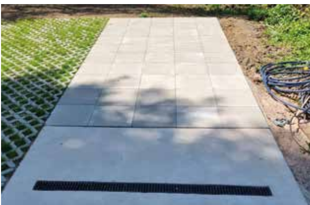
Beispielfundament: Waschbetonplatten mit gegossener Platte und ACO Rinne welche später unter dem Vordach ist.
